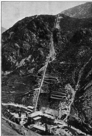
FIG. 1. — L'AMÉNAGEMENT DES CHUTES D'EAU EN ANDORRE : Vue de l'usine d'Escaldes et de sa conduite forcée.
